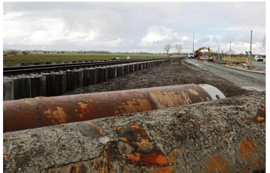
Alte Abstellgleise mussten weichen. Auch sonst hat sich im Bahnhof Sande schon einiges getan (links). Zudem wurden Sperrzeiten am Wochenende genutzt, um an der Abzweigung „Weißer Floh“ Spundwände an der bestehenden Bahntrasse ins Erdreich zu rammen (Foto rechts). Rechts davon wird einmal das zweite Gleis verlaufen.
