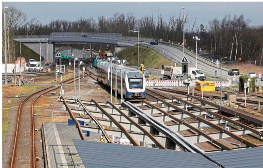
Alte Abstellgleise mussten weichen. Auch sonst hat sich im Bahnhof Sande schon einiges getan (links). Zudem wurden Sperrzeiten am Wochenende genutzt, um an der Abzweigung „Weißer Floh“ Spundwände an der bestehenden Bahntrasse ins Erdreich zu rammen (Foto rechts). Rechts davon wird einmal das zweite Gleis verlaufen.
