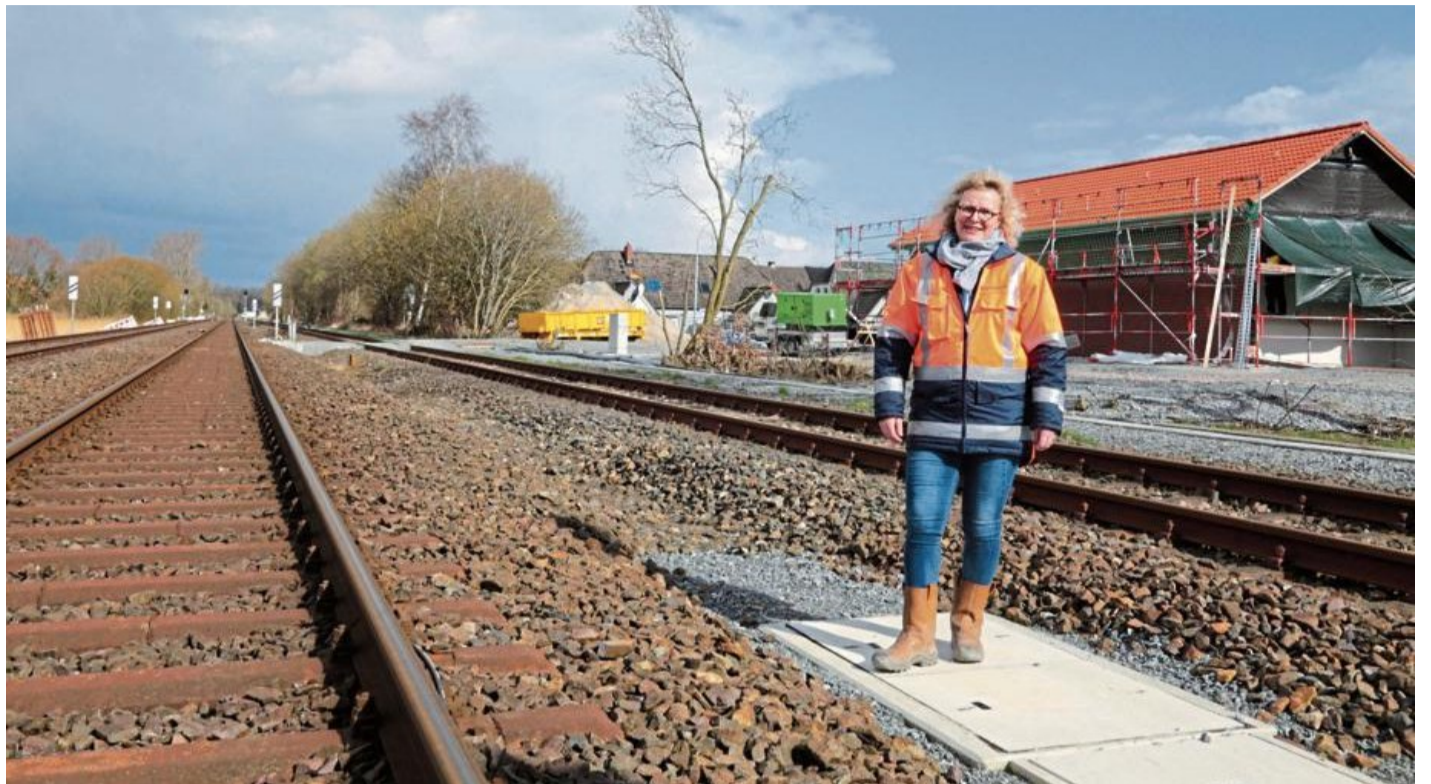
Kein Zug in Sicht: Projektleiterin Jutta Heine-Seela an der Bahnstrecke Richtung Wilhelmshaven, die aktuell gesperrt ist. Rechts im Hintergrund ist das neue elektronische Stellwerk zu sehen.
