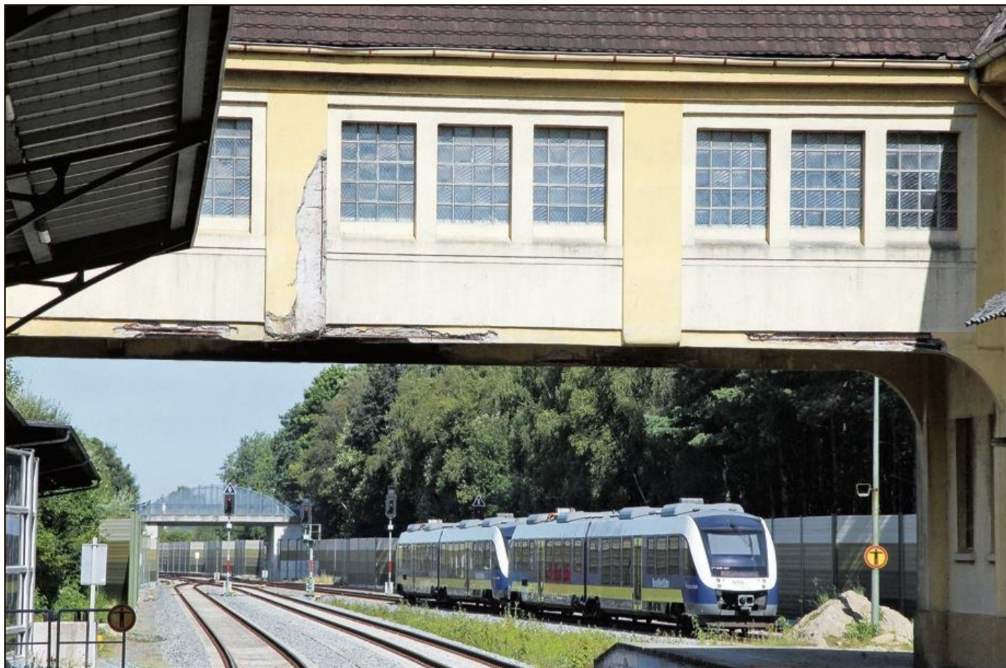
Historisch, aber derzeit nicht gerade hübsch anzusehen: Die Fahrgastbrücke im Varel-Bahnhof soll um 80 Zentimeter erhöht und dabei gleich saniert werden. Doch die Ausschreibung ist fehlgeschlagen – es droht Verzug. WZ-FOTO: LÜBBE
