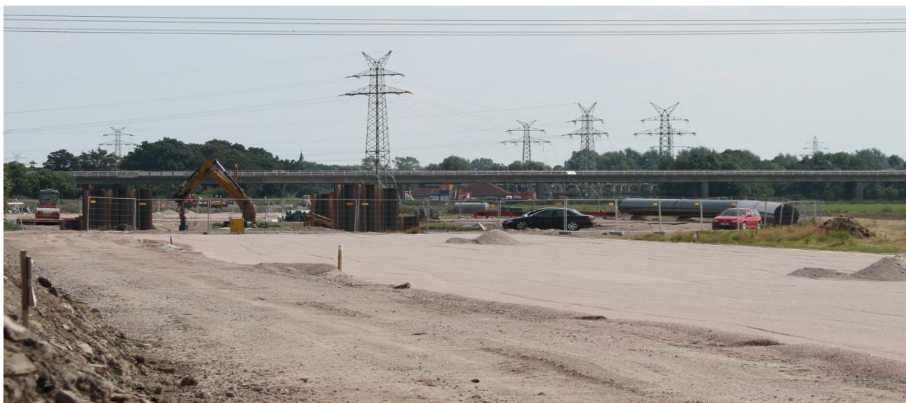
Bild zeigt das neue Planum Richtung Sande / Autobahnbrücke A 29
