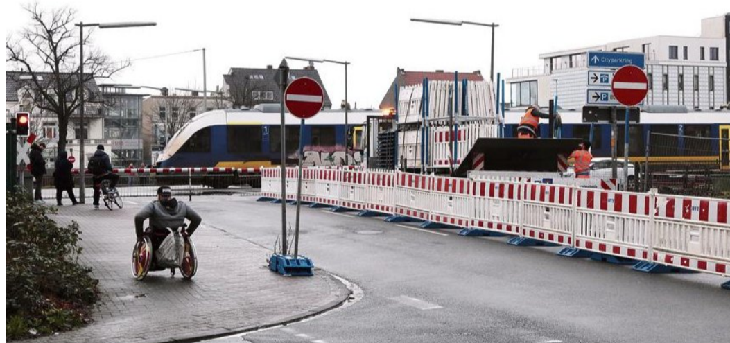
Der Zugverkehr ist von den Arbeiten am Bahnübergang nicht betroffen. Die Luisenstraße/Mitscherlichstraße ist jedoch nur
